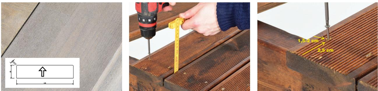
MøreRoyal®-Terrassendielen müssen immer mit der Sichtseite, welche Sie an der geriffelten oder fein strukturierten Oberfläche sowie den gefasteten Längskanten erkennen, nach oben verlegt werden.
